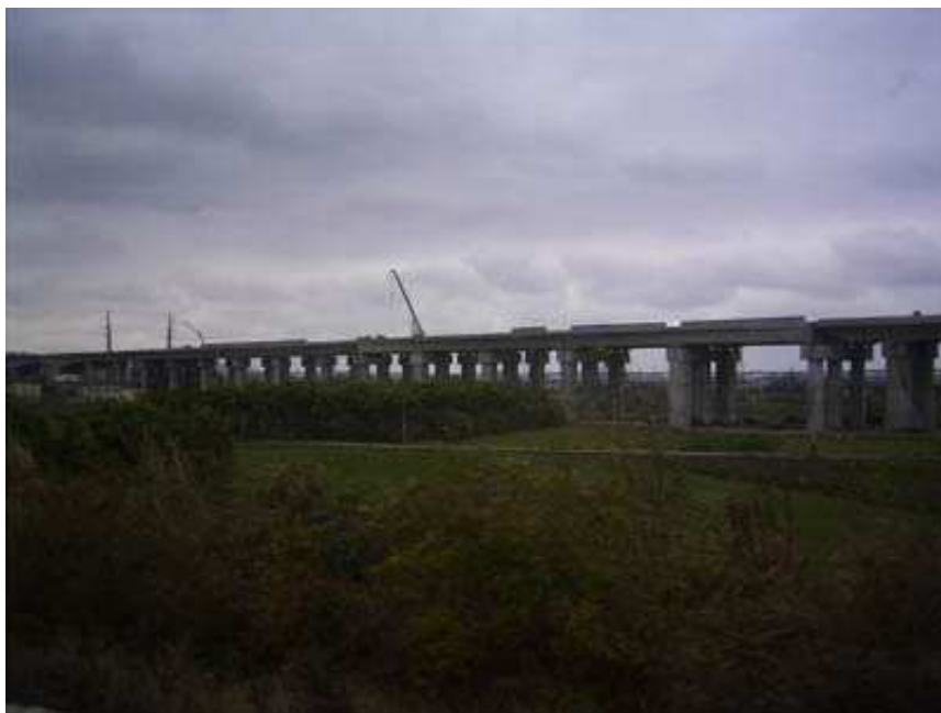
28 2Noch ist die Schnellstrecke im Bau. Die Pfeiler und Brücken stehen schon, hier werden gerade die Geländerelemente montiert. Dann müssen Schienen und Oberleitung folgen. Im Herbst 2004 soll der erste Probebetrieb auf einer kurzen Strecke in Südtaiwan stattfinden, die Eröffnung der ganzen Strecke ist erst für November 2005 geplant.
